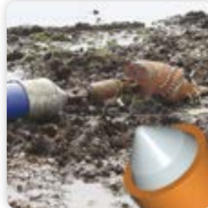
7 - Horizontales Bohren HDD
